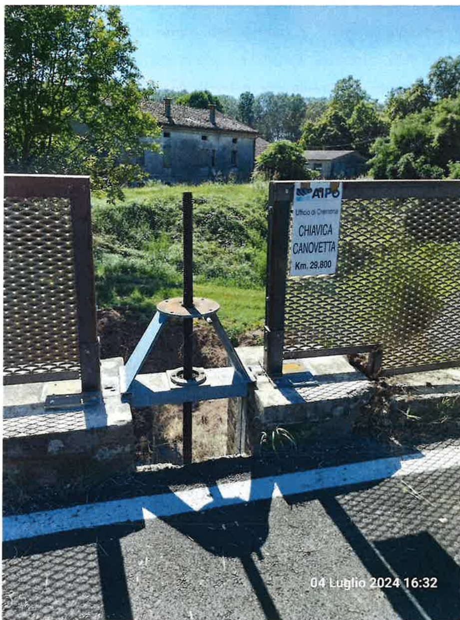
Chiavica CANOVETTA sprovista del dispositivo di azionamento
