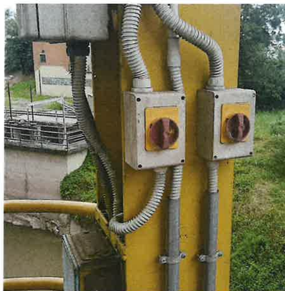
Particolari degli interruttori di sezionamento e manovra
